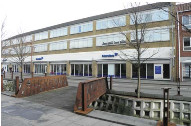
Dæmningen 66. Sprogcentret er flyttet ind på 1. sal og har til huse bag de fem store vinduer fra højre.
